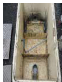
3ヶ月後、油脂の堆積は増加したが臭気は引き続き大幅に改善している。
