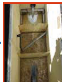
投入終了後、引抜10日で既にこの油脂の堆積。
